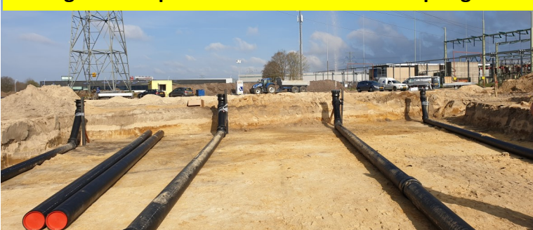
Leidingwerk los punt tankauto's & toevoer opslag silo's
